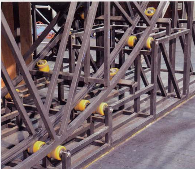
Système de guidage extérieur au sol
